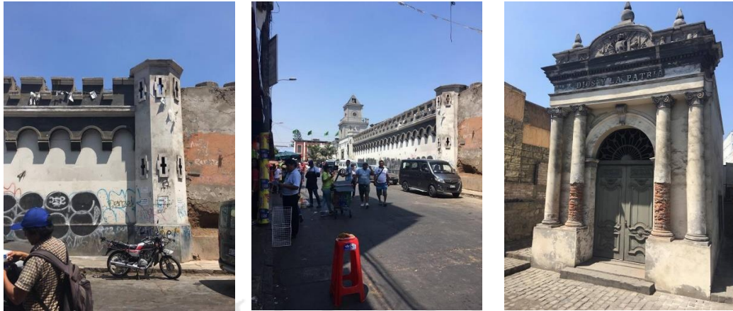
Figura 41 Imágenes del estado actual del exterior del Cuartel Santa Catalina –
