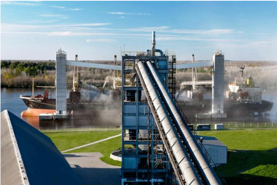
Figura 2.15 Zona de almacenamiento de granel sólido Terminal Las Palmas-España
