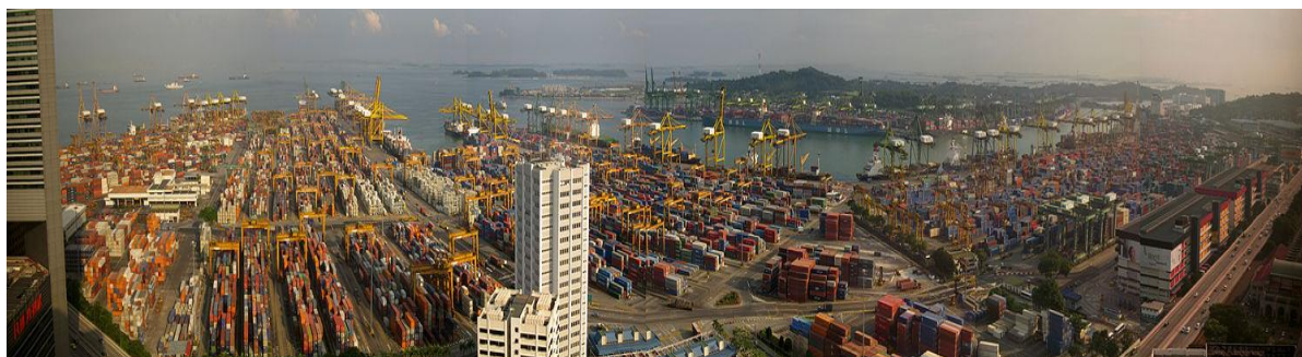
Figura 1.8 Puerto de Singapur
