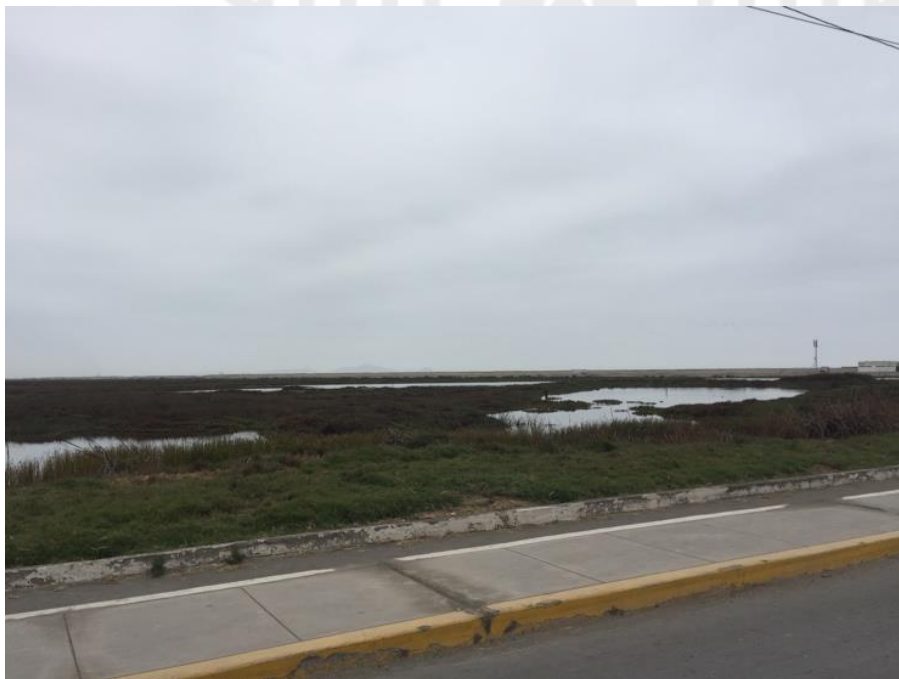
Figura 6.66 Pavimento de Av. La Playa
