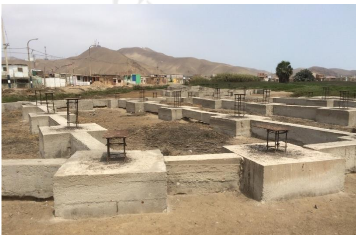
Figura 6.41 Foto de cimientos
