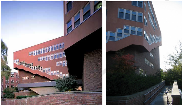
Figura 5.22: Vistas de la fachada posterior
