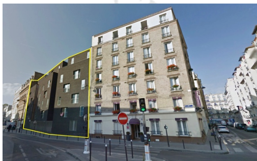
Figura 5.20: Fotografía de la fachada
