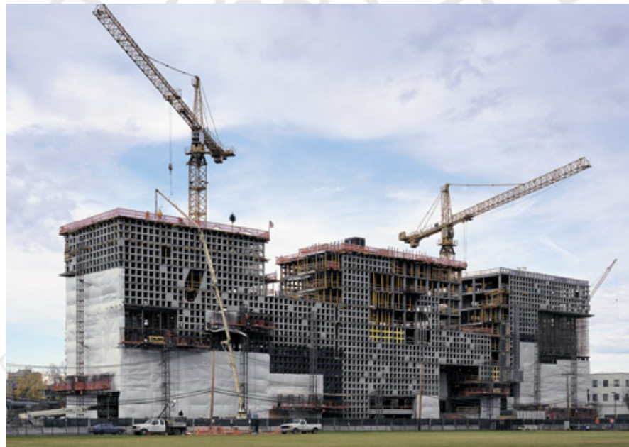
Figura 5.9: Simmons Hall en proceso de construcción
