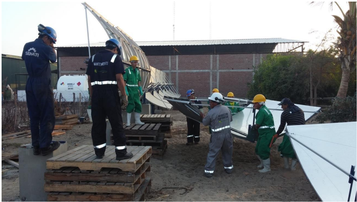
Montaje de colectores solares parabólicos.
