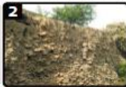
2 Removieron la tierra y quitaron las cascadas, dejando una capa de limo de 1,5 m aproximadamente.
