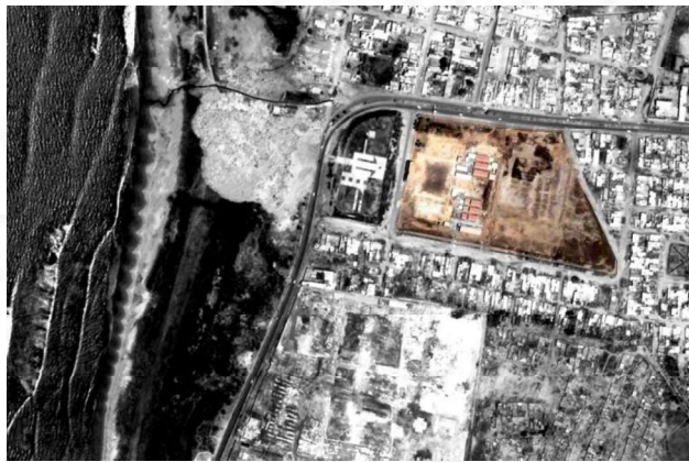
Figura 36 Foto área, primera etapa finalizada
