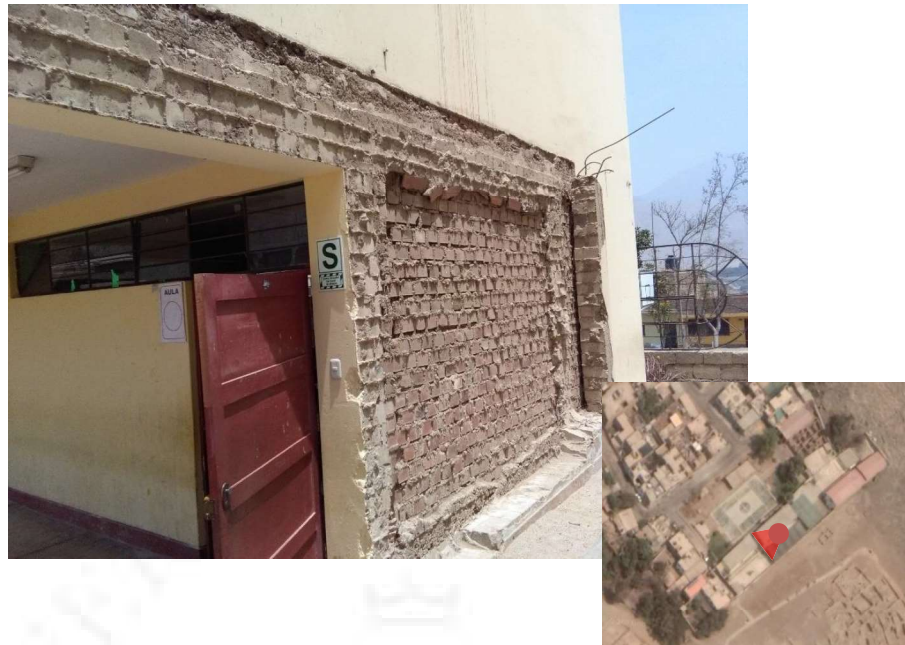
Figura 14 Estado actual de la estructura del colegio
