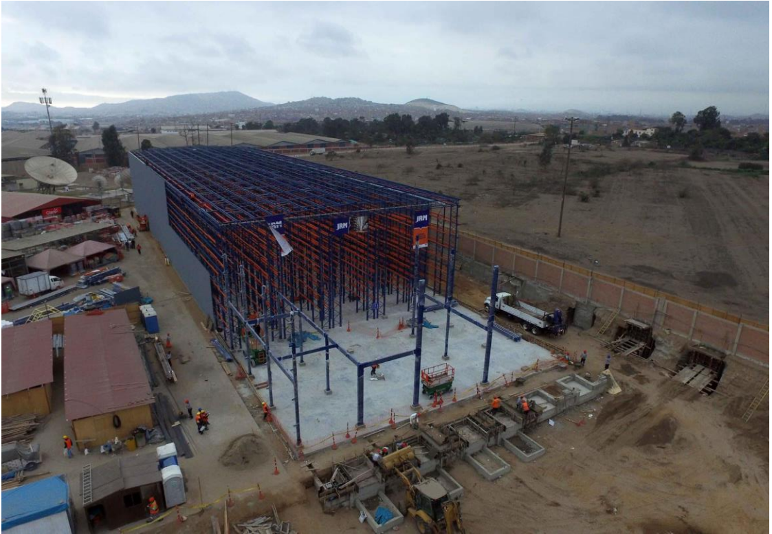
Centro de Distribución de Claro en plena construcción
