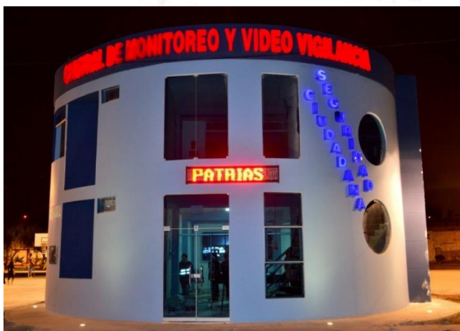
Figura 3.2 Central de seguridad ciudadana en avenida Huamán
