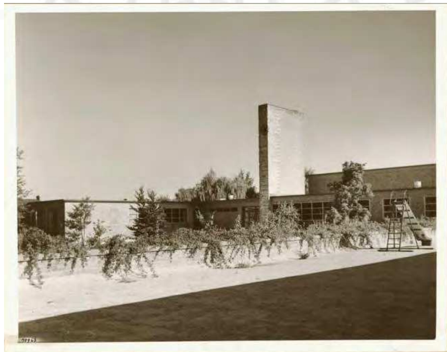
Figura 25 Fachada del colegio Crow Island en Chicago.
