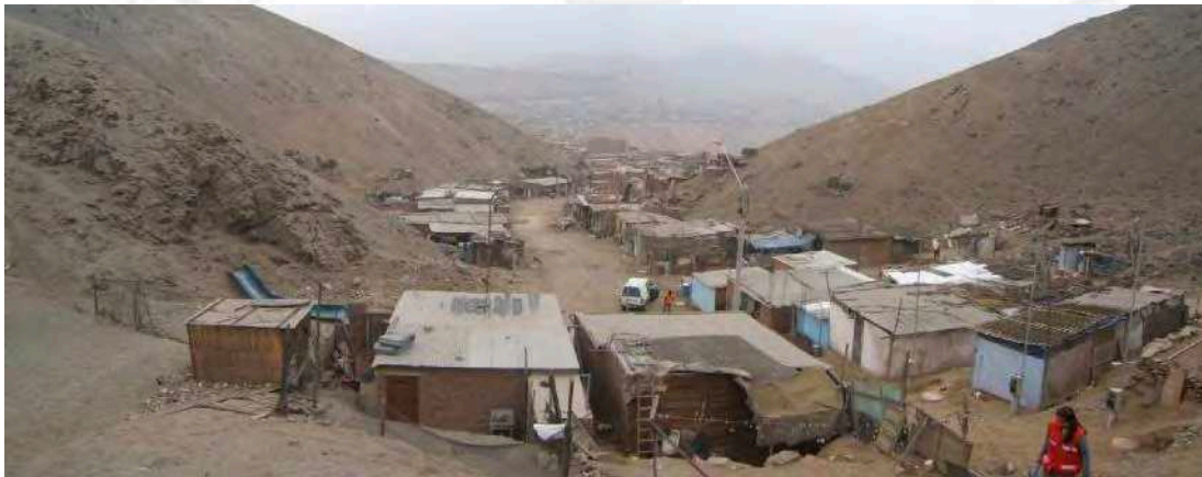
Figura 90 Zona vulnerable a derrumbes
