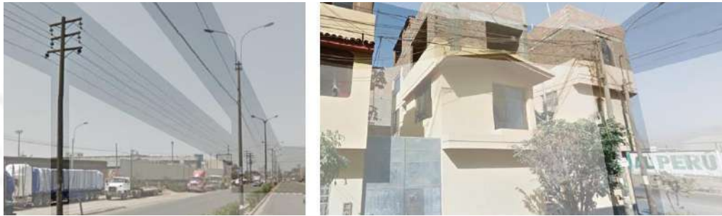
Figura 114 Contaminación visual en avenidas y calles
