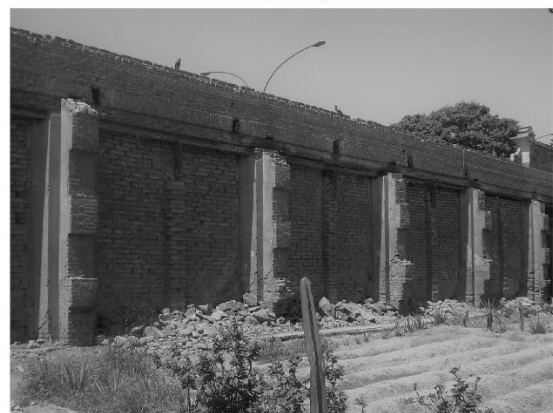
Parte posterior muro
