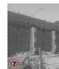
Parte posterior muro
