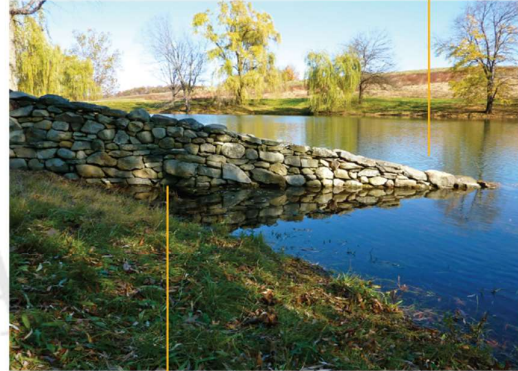
REMATE DEL MURO
