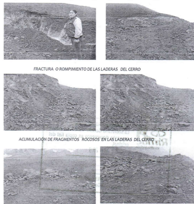
Figura 6.3 Fotos de inspección
