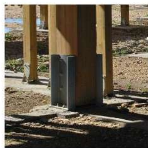
Marcos de ventanales y elementos de unión estructural
