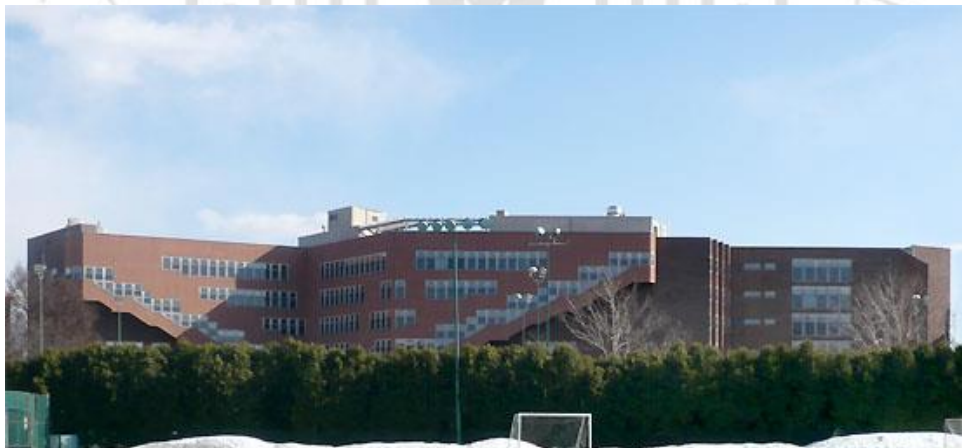
Figura 5.134 Vista Baker House
