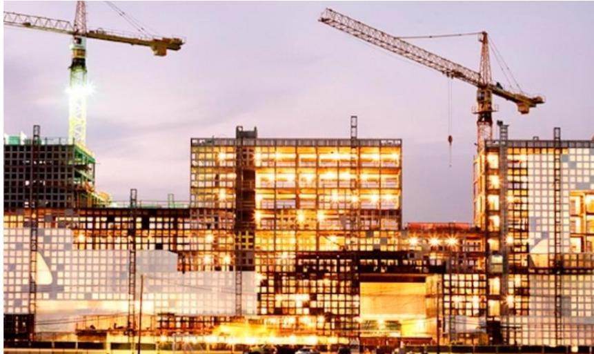
Figura 5.81 Simmons Hall en construcción
