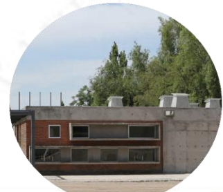
MUROS DE CONCRETO Y LADRILLO
