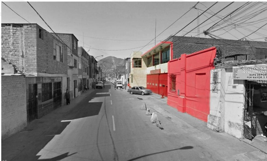
Actual Estación de Bomberos Rímac 21
