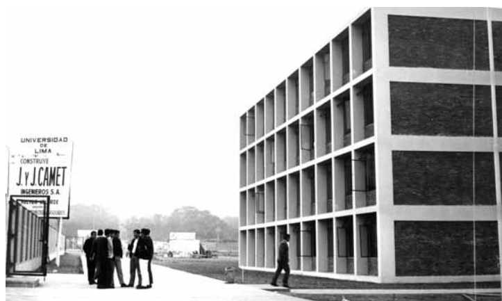
Figura 7. Edificio A terminado que mira hacia el oeste, 1966. Fuente: Departamento de Administración Documentaria, Universidad de Lima
