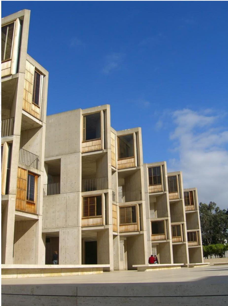
Fachada mueble - Salk institute
