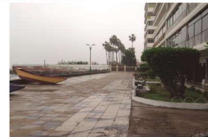
1.- El muro de la FAP divide el malecon
