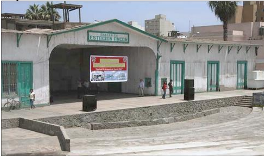
Imagen 2.8: Vista 1 Estación ferrocarril de Ancón
