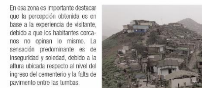
3 ACCESO INFORMAL AL CEMENTERIO INSEGURIDAD Y SOLEDAD
