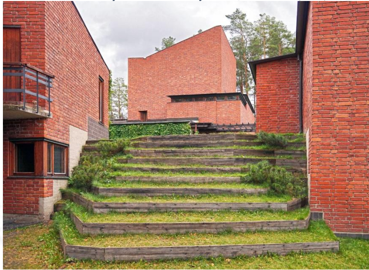
Figura 3.16 Exterior del ayuntamiento de Säynätsalo, Alvar Alto (1949)
