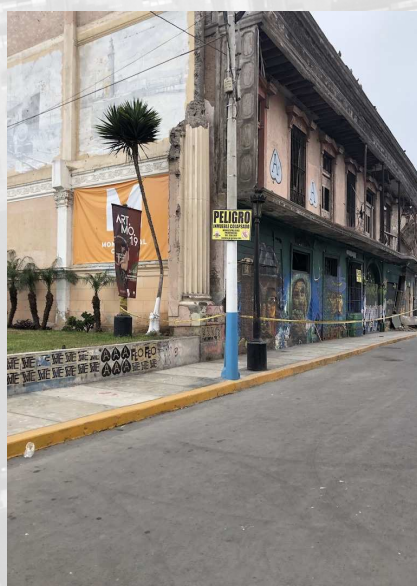
Inmueble colapsado en la Calle Daniel Nieto
