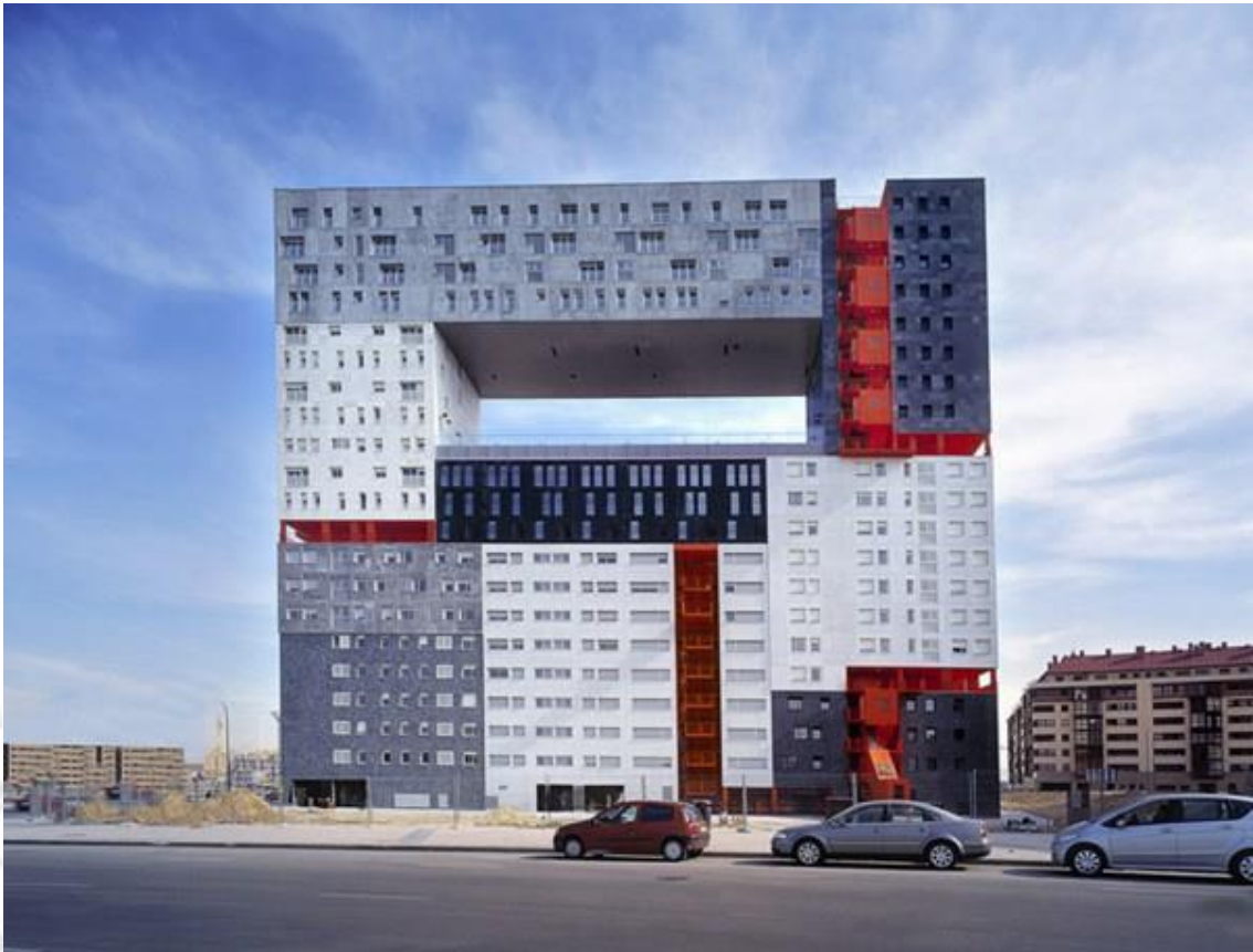
Imagen 74. Foto del edificio de Mirador, MRVDV
