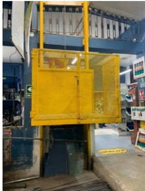
Instalación de elevador montacarga para evitar fatiga
