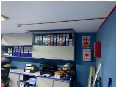
Instalación de implementos de seguridad en oficinas
