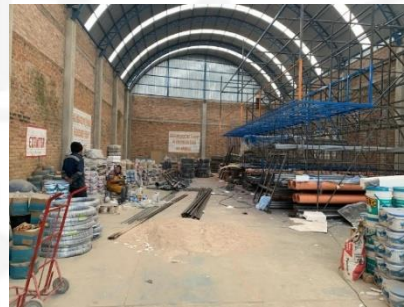
Trabajos en el nuevo almacén Colonial.
