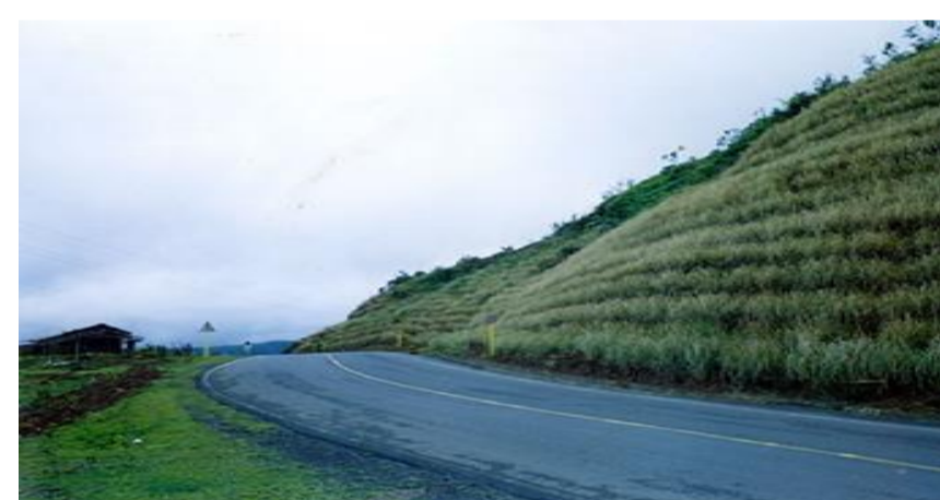
Figura 1. Talud con Vetiver. Vetiveria (2020).
