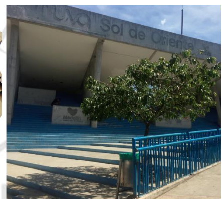
Teatro abierto - Fachada principal
