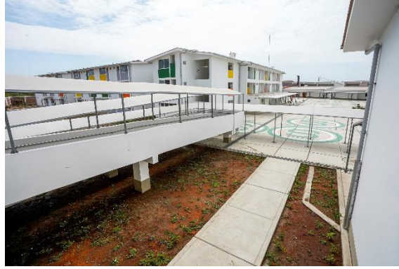
Figura 52. COAR Piura – Patio central y rampa de acceso a pabellones
