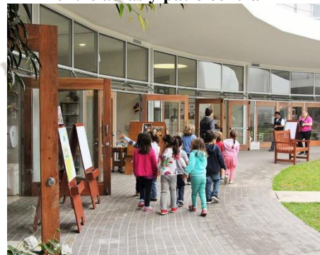
Figura 41. Colegio Aleph – Conexión entre aulas y patio central
