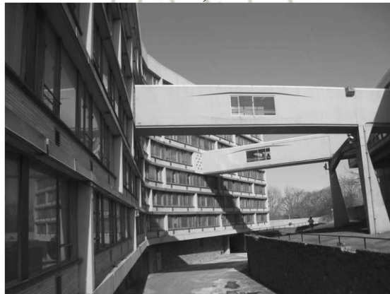
Figura 77. Julius Silver Residence Center, Universidad de Nueva York, 1956-1961.
