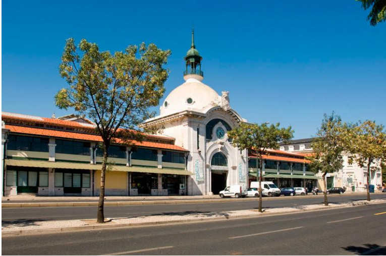
Fachada principal del mercado Da Ribeira
