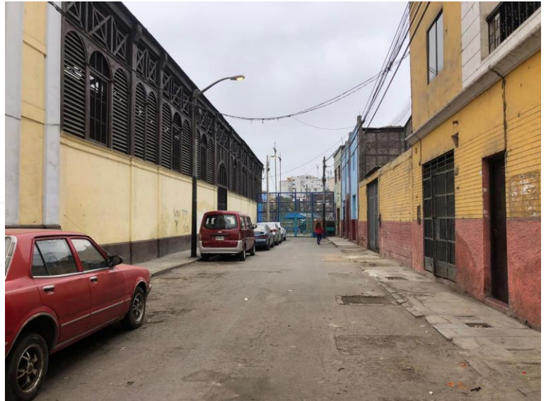
Figura 6.6 Fachada Oeste del Mercado de Baratillo – Pasaje El Chalaco
