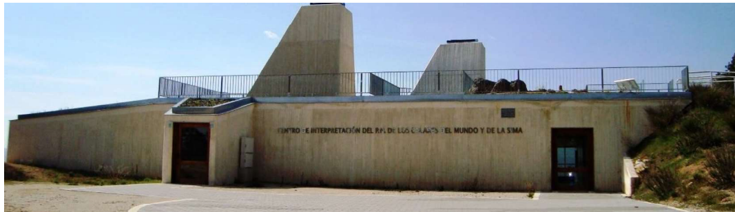
Vista del edificio
