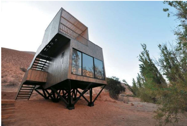
Vista exterior de la cabina elevada
