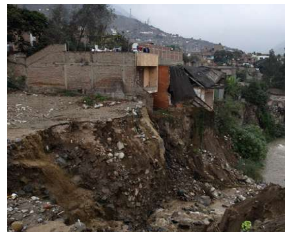
Fig. 1.10: Viviendas colapsadas por huaico en Chosica. Fuente: Radio Nacional.
