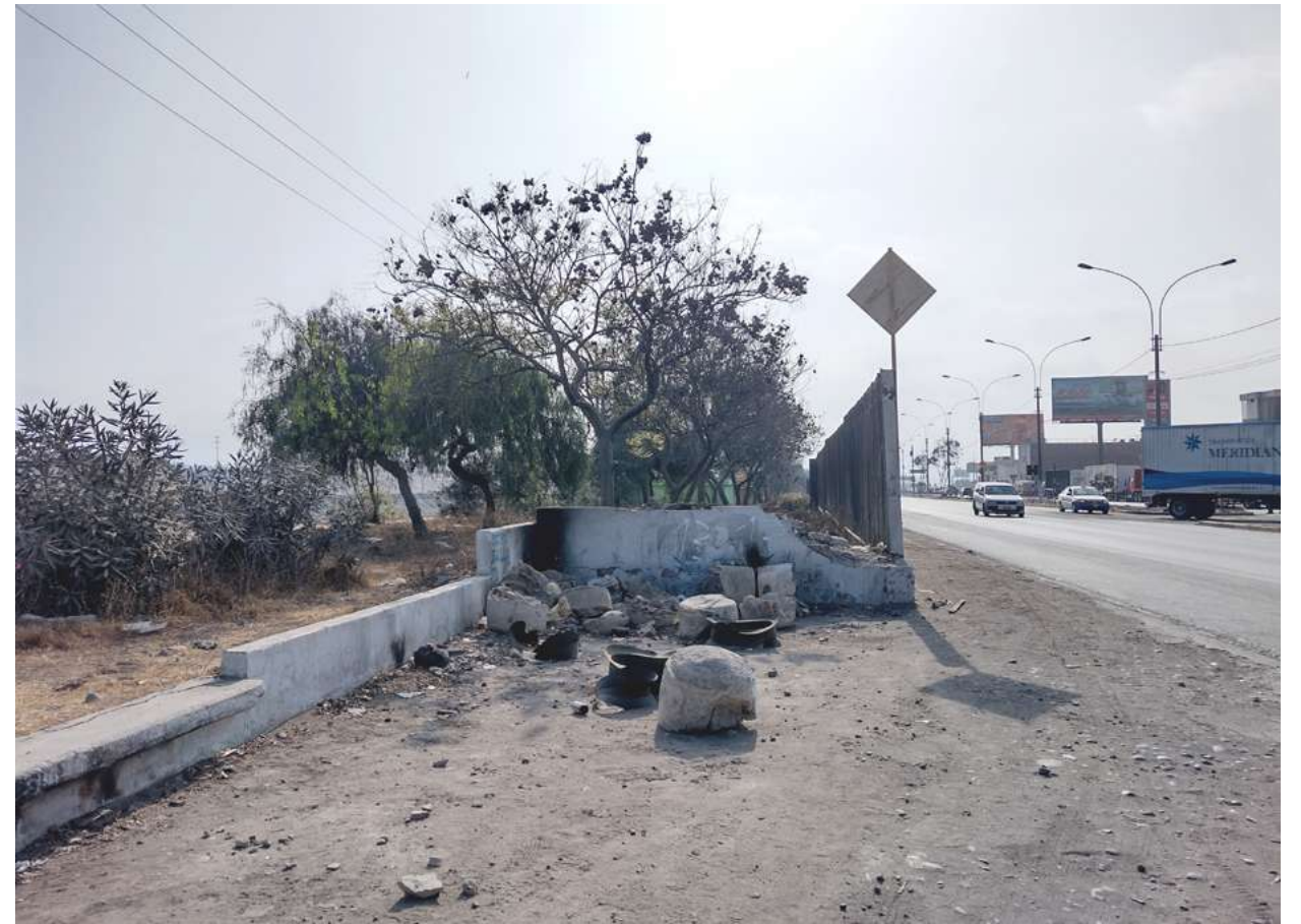
Fig. 1.6: Fotografía con vista del borde del río Rímac del muro perimétrico existente en la vía Ramiro Priale Fuente: Elaboración propia
