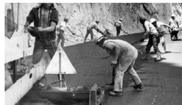
Figura 2.85: Construcción de la Carretera Central Fuente: El Comercio
