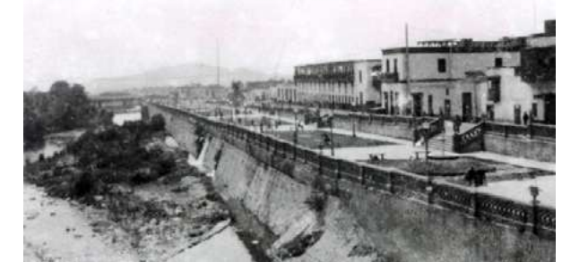
Figura 2.97: Malecón Leguía de la década de los cuarenta, luego demolido para la construcción de la Vía Evitamiento Fuente: Lima la Única
