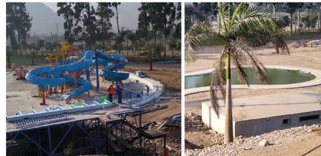
PARQUE TEMÁTICO EN CONSTRUCCIÓN (ATE)
