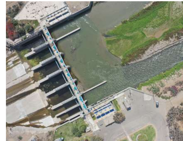
Figura 4.39: Vista aérea de la bocatoma de la Atarjea Fuente: Sedapal
