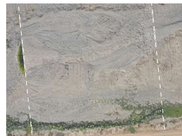
Figura 2.114: Foto aérea de la intervención ingenieril en el cauce
