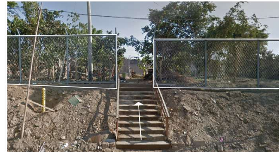
PARQUE (SAN MARTÍN DE PORRES) Parque deteriorado en el borde del río Rímac con un cerco perimétrico por seguridad, el cual dificulta la visibilización al río. Asimismo, controla el ingreso hacia el parque. Por las condiciones, parece ser construido por la población.
