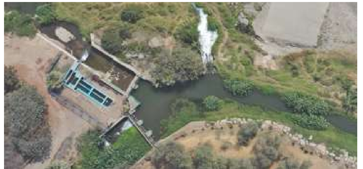
Bocatoma canal de río Surco
