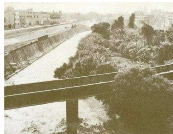
Figura 2.83: Puente del Ferrocarril Lima Ancón Fuente: Lima La Única
