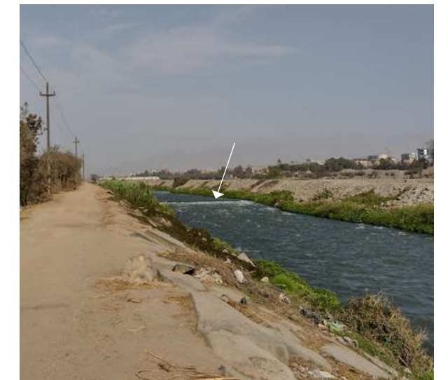
Figura 2.115: Río Rímac en Santa Clara donde se observa la intervención en el cauce
