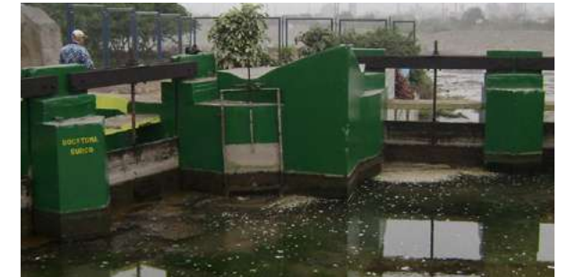
Figura 4.38: Bocatoma del canal Surco Fuente: Sedapal
