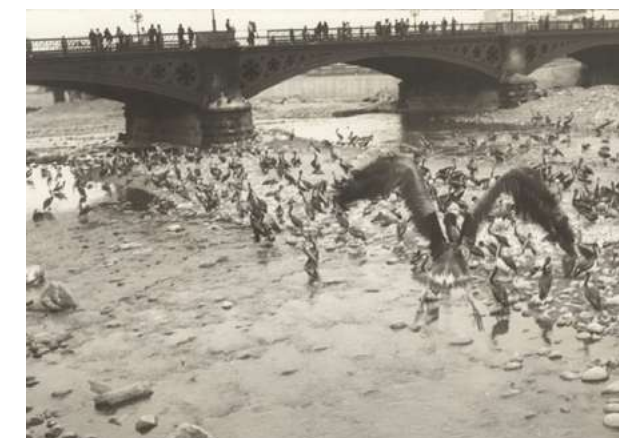
Figura 2.95: Puente Balta 1960 Fuente: Revista Cosas
