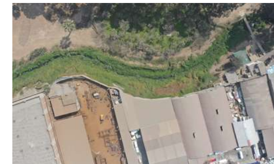
Figura 3.59: Borde duro compuesto por fábricas
