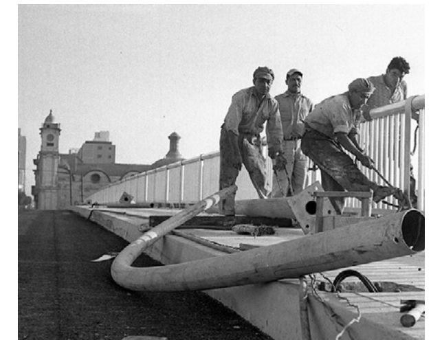
Figura 2.94: Puente Santa Rosa construida en la década de los cincuenta
