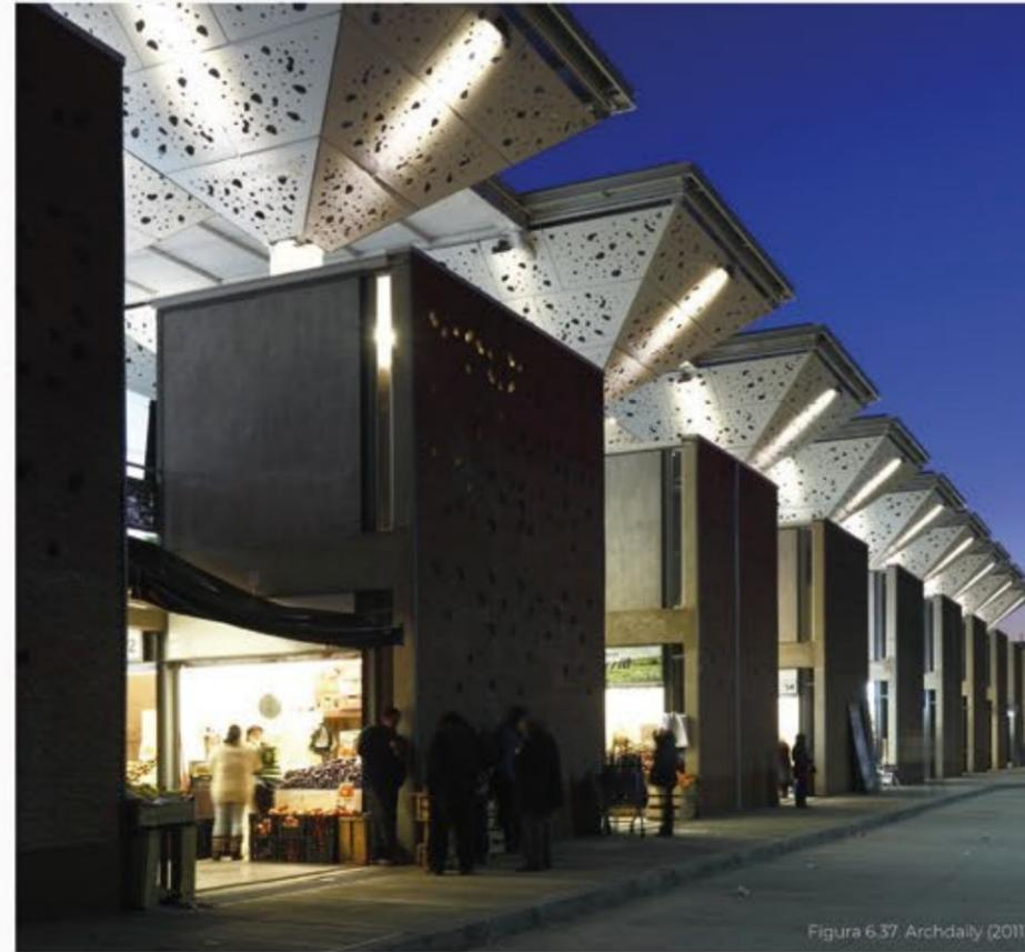
El mercado Tirso de Molina tiene gran parte de su atractivo en su cubierta. El techo del proyecto se apoya sobre una trama de altos pilares. La agrupación de módulos de la cubierta tienen una medida de 6 metros por 6 metros, los cuales definen una planta libre y flexible para la instalación de los puestos en 2 niveles (Dearq, 2015).
