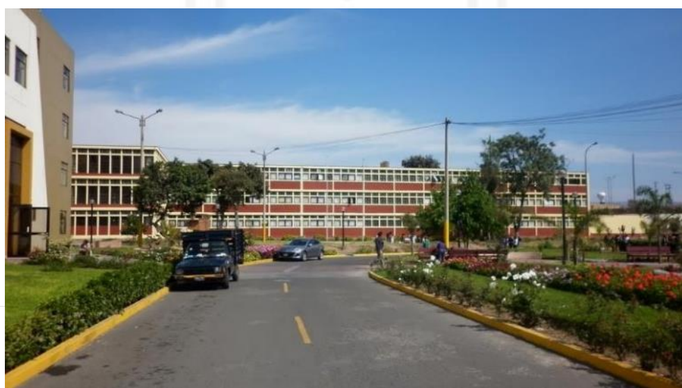
Ilustración 2.45 Vista fachada noroeste Residencia Universitaria UNMSM
