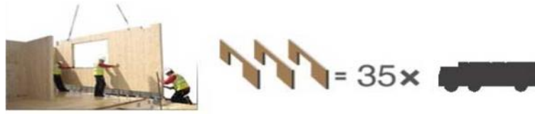
Ilustración 5.14 Módulos Prefabricados para Dormitorios
