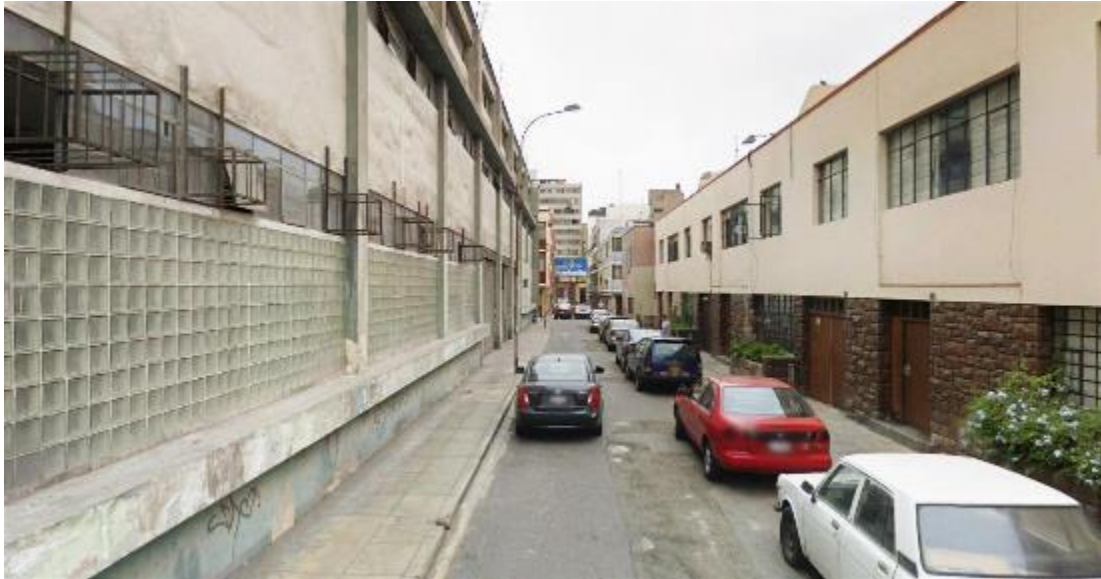
Figura 7.67: Fotografía de Fachada Residencial frente a Muro Ciego en Pasaje Torres
