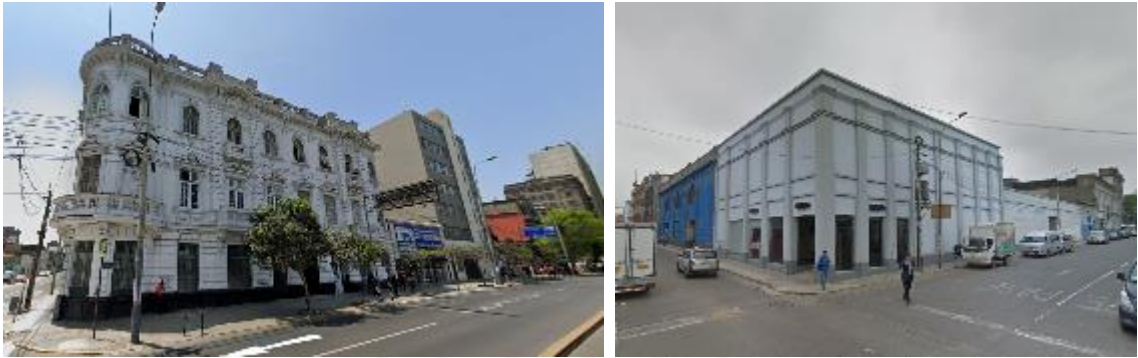
Figura 9.7: Fachadas Vecinas del lote del Proyecto
