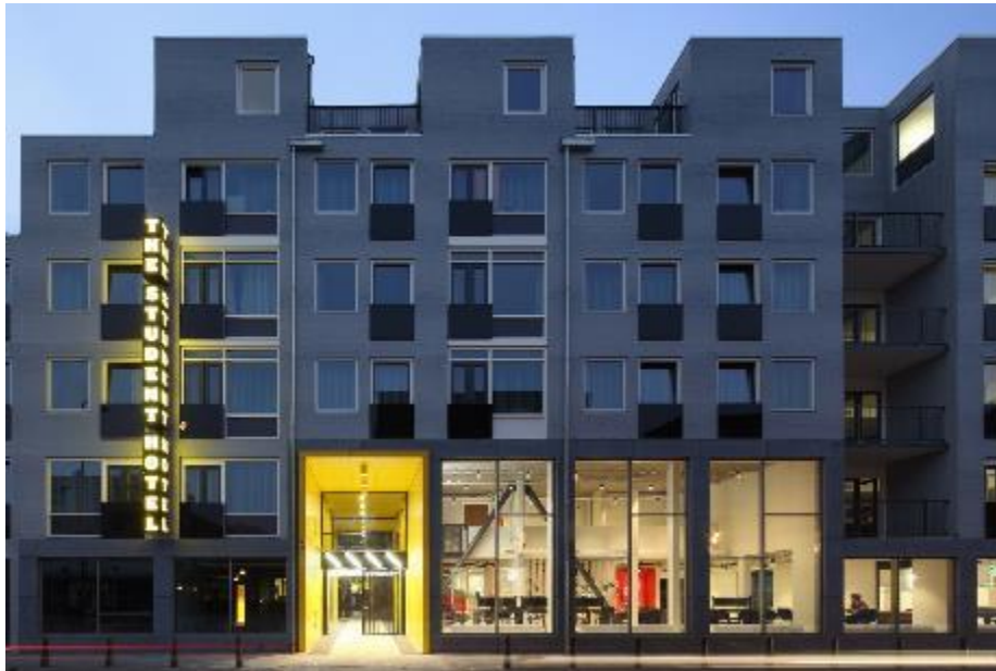
Figura 6.1: Fachada de The Student Hotel en La Haya
