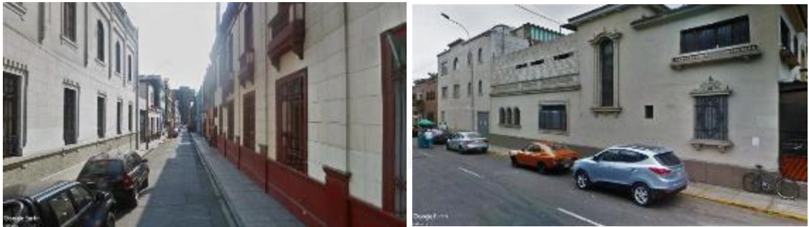
Figura 7.50: Fachadas Cerradas en el Jr. Chíncha (Izq.) y Jr. Tarma (Der.)
