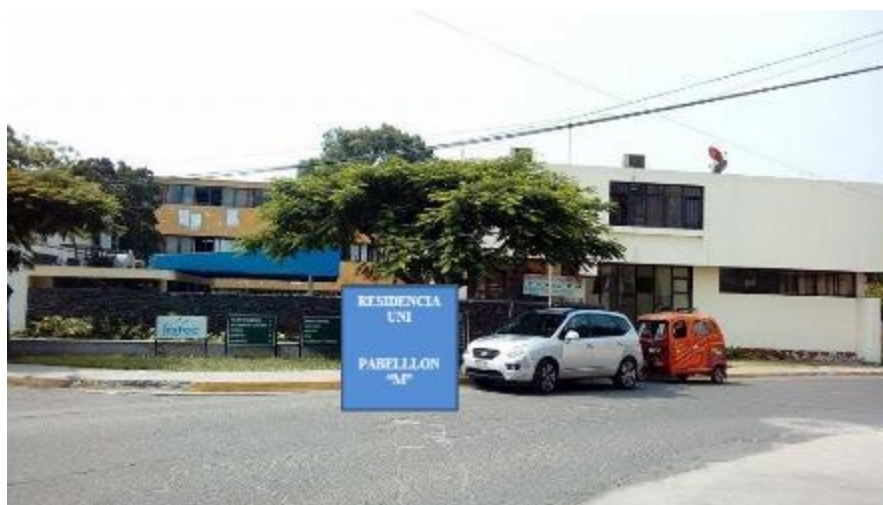
Figura 3.7: Residencia Universitaria de la UNI “Pabellón M”
