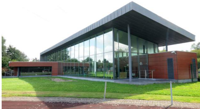
Fachada del Centro
