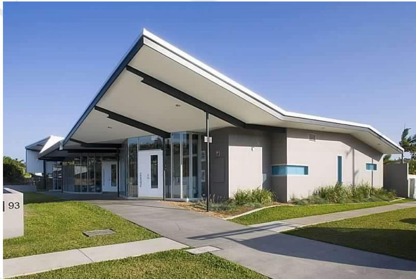
Fachada del Centro
