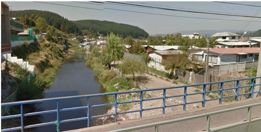
Figura 20 Vista del contexto
