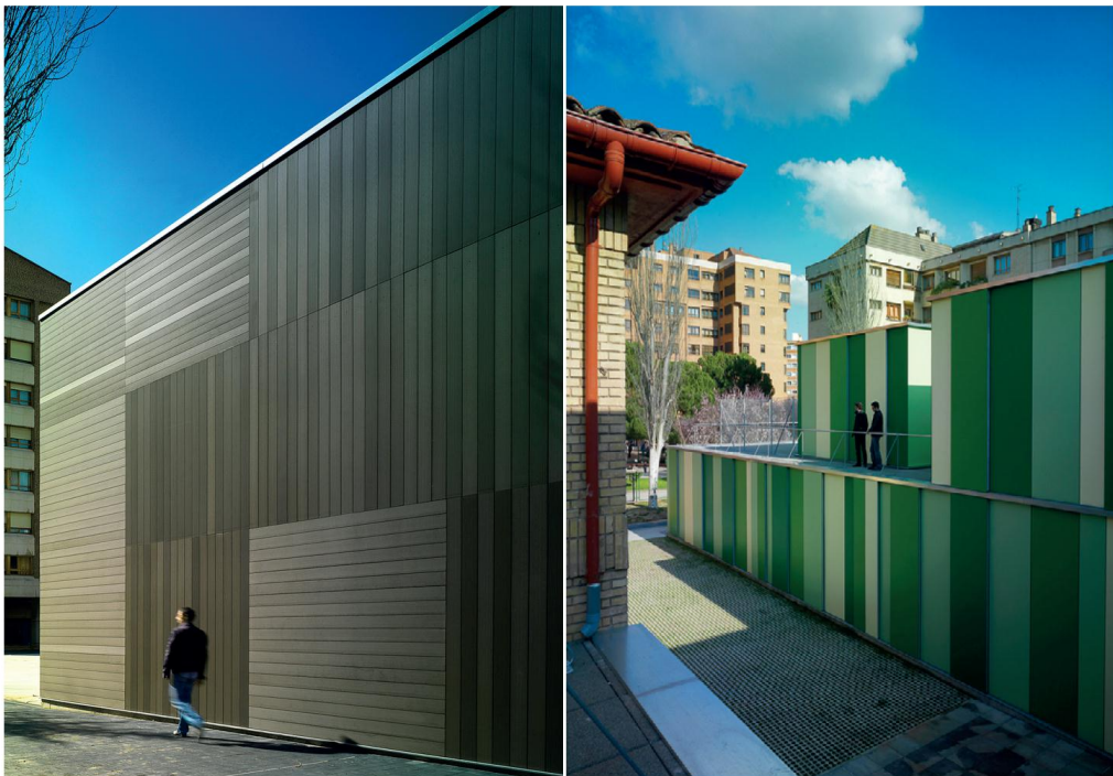
Figura 12 Imágenes del colegio Fray Pedro Ponce de León, fachadas
