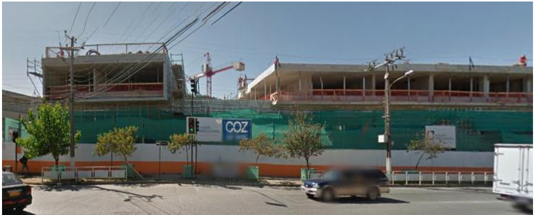
Figura 21 Imagen del proceso constructivo
