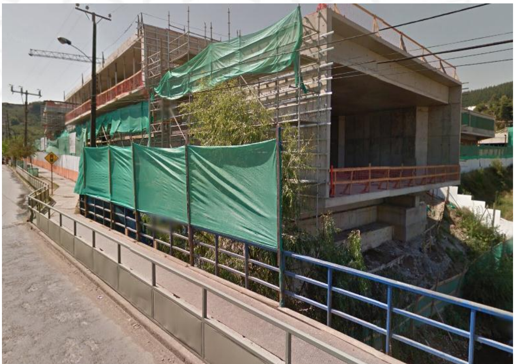
Figura 22 Imagen del proceso constructivo
