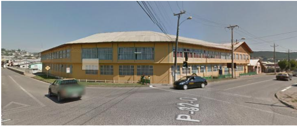
Figura 19 Vista del contexto
