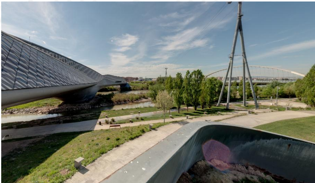
Figura 32 Vista del contexto
