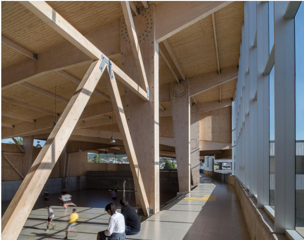
Figura 23 Imagen de la estructura del gimnasio
