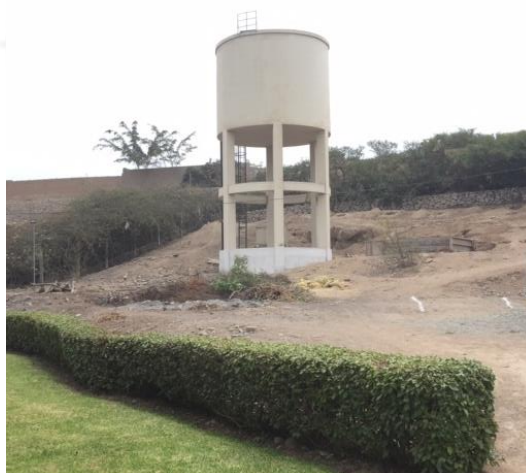
Figura 2.23 Fotografía 8: tanque de agua de Aldea
