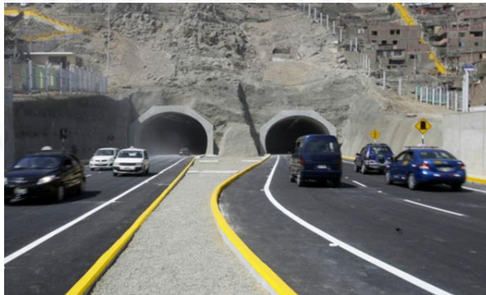
Figura 6.2 Túnel Santa Rosa – San Martín
