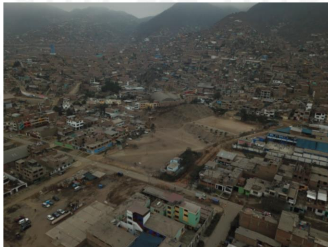
Figura 6.13 Vista terreno en el Ca. Los Eucaliptos
