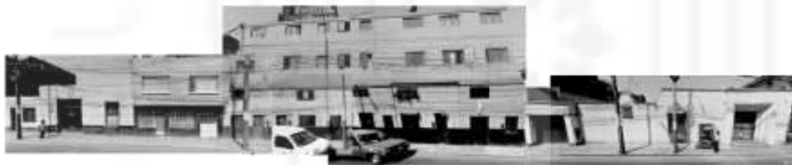
Fachadas con carencias de retiros
