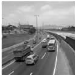
Vía de Evitamiento
