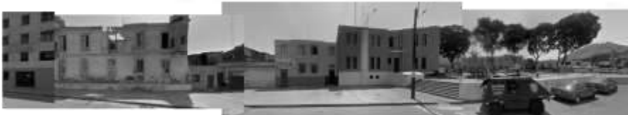
Fachadas en Av. Loreto frente al terreno de la antigua Alameda de Acho
