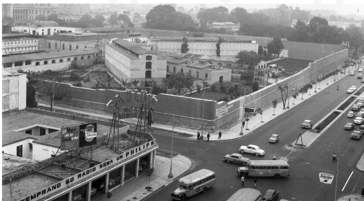
Imagen 21: Cruce de la Av. Bolivia con Av. Garcilaso de la Vega en el tiempo de la Penitenciaría de Lima.
