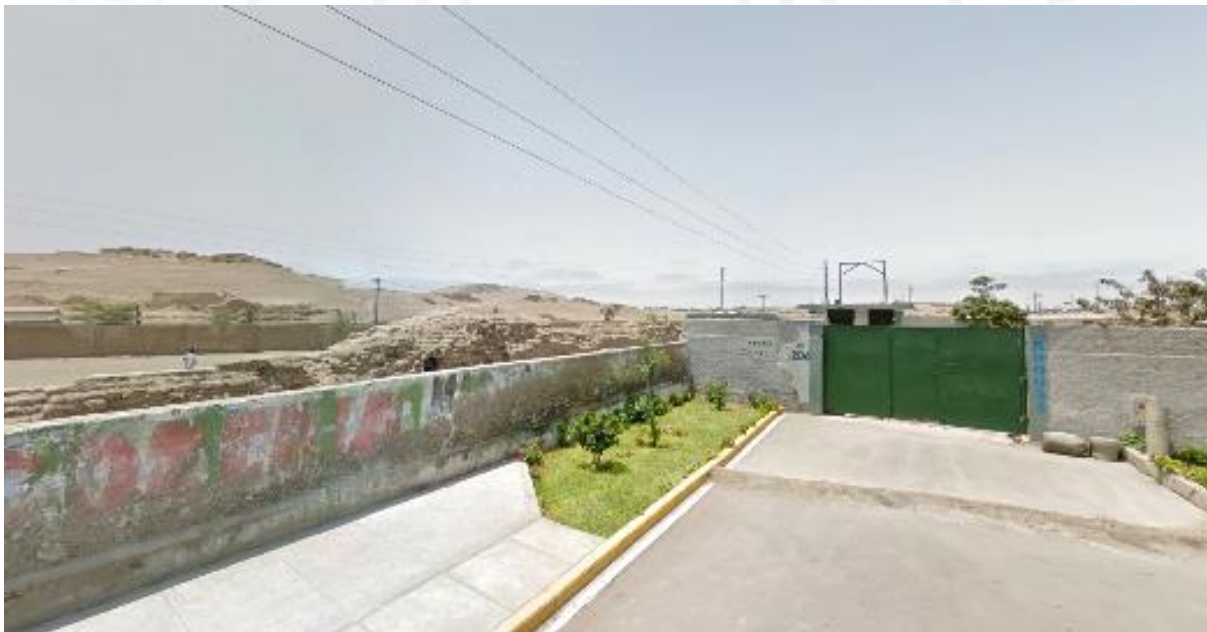
Imagen 50: Ingreso principal al sector norte (vista de la muralla) – Fuente: https://www.google.com/maps
