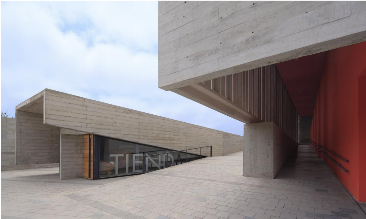
Imagen 75: Ingreso a la sala de exposición y la tienda – Fuente: https://www.archdaily.pe
