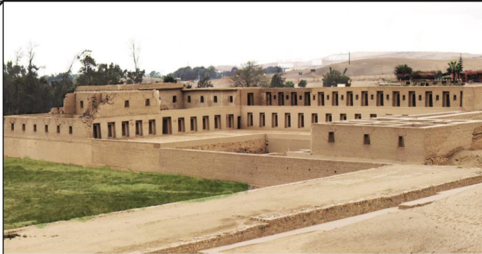
INICIO DE TRABAJOS DE RESTAURACIÓN
