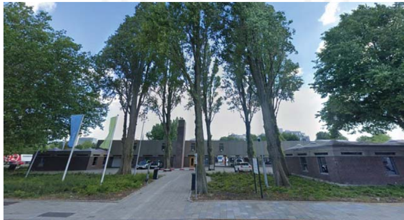
Figura 2-11 Fachada principal del orfanato
