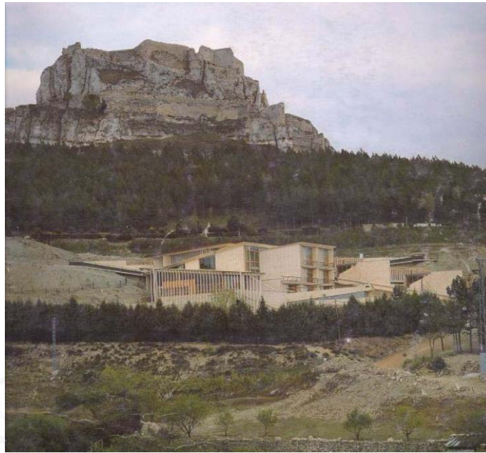
Figura 5-2 Vista al proyecto desde la parte baja de la pendiente del cerro
