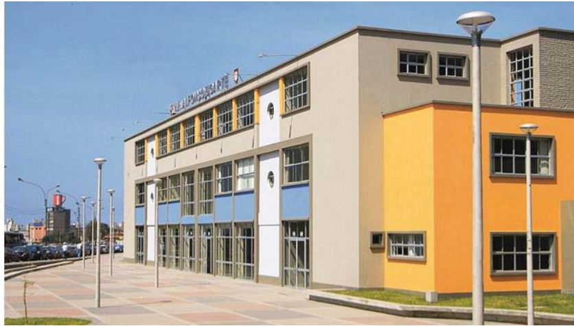
Figura 2-34 Fachada del colegio remodelada en el 2010
