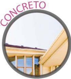
Muros y techos de concreto blanco
