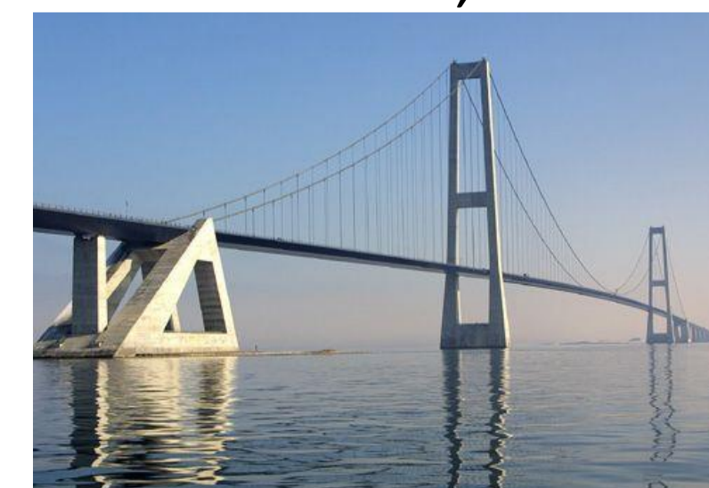
Figura 3. Puente colgante Great Belt. Fuente: Structuralia (2015)
