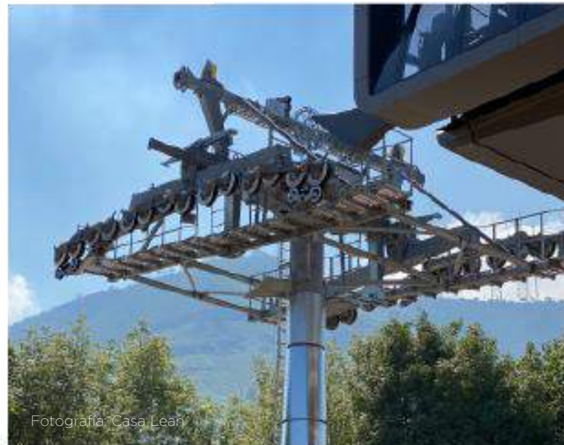
Fotografía: Casa Lean
