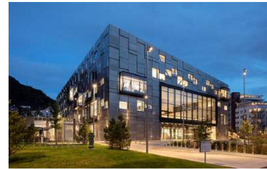
University Kunst- og Designhøgskolen i Bergen, Statsbygg (Completed 2017)
