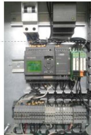
Instalación de PLC
