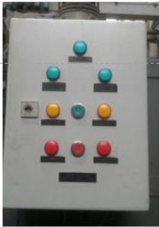
Cambio de tablero general de DFE
