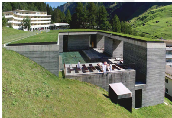
Vista externa de Termas de Vals Fuente: Kazunori Fujimoto
