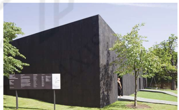
Vista exterior del pabellón
