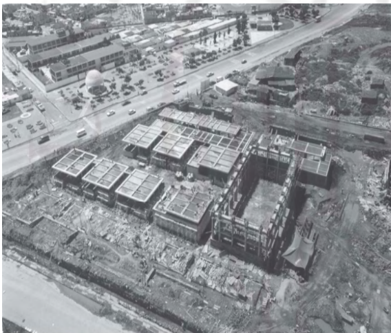
Etapa de construcción de Centro para Invidentes y Débiles visuales Fuente: Taller de Arquitectura - Mauricio Rocha
