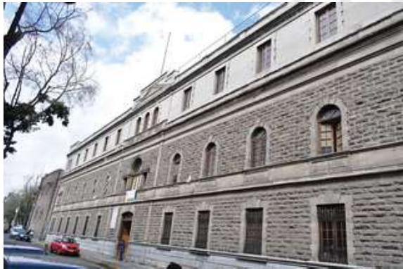
Fachada de la Escuela Nacional de ciegos Fuente: CNDH
