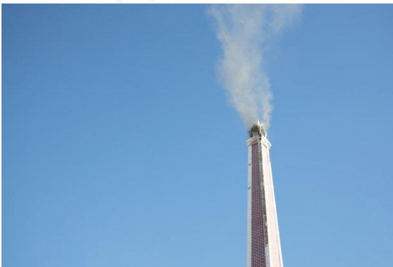
Chimenea de Crematorio
