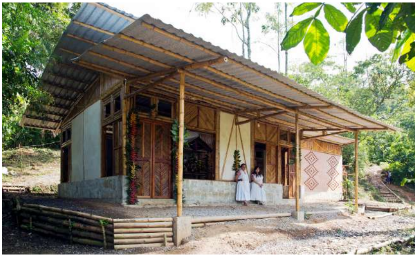
Figura 2.33 Vivienda Social Fuente: www.archdaily.pe , 2015
