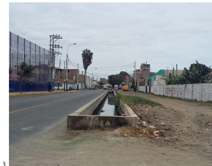
1.2.3. Canal Surco en medio de circulación vehicular en Av. Alameda San Marcos
