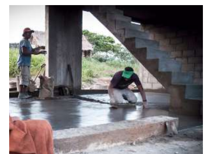
Figura 2.32 Procesos Constructivos Fuente: www.archdaily.pe
