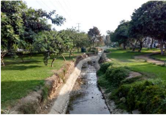
Figura 4.48 Canal Surco en San Borja
