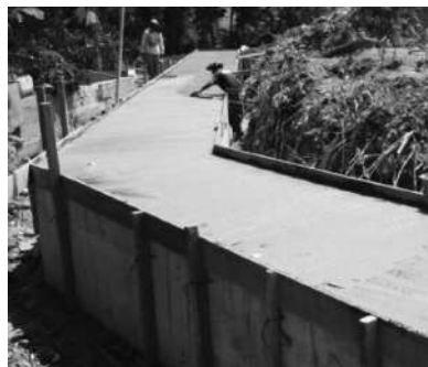
Figura 1.6 Canalización, El Agustino Fuente: CUSH, 2017
