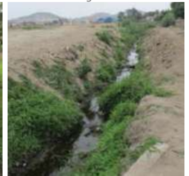
Tramo 4 - Santiago de Surco
