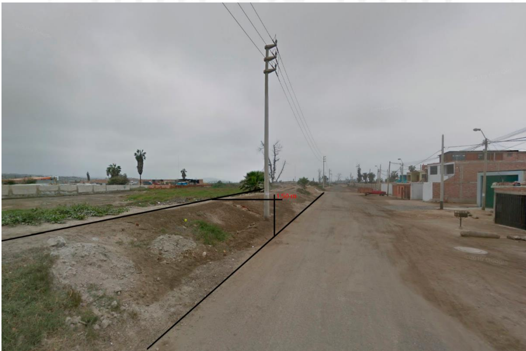
Figura 6.37 Desnivel del terreno
