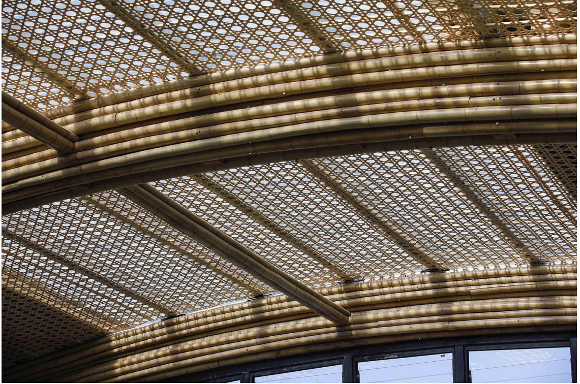
Figura 5.62 Vista interior de vigas
