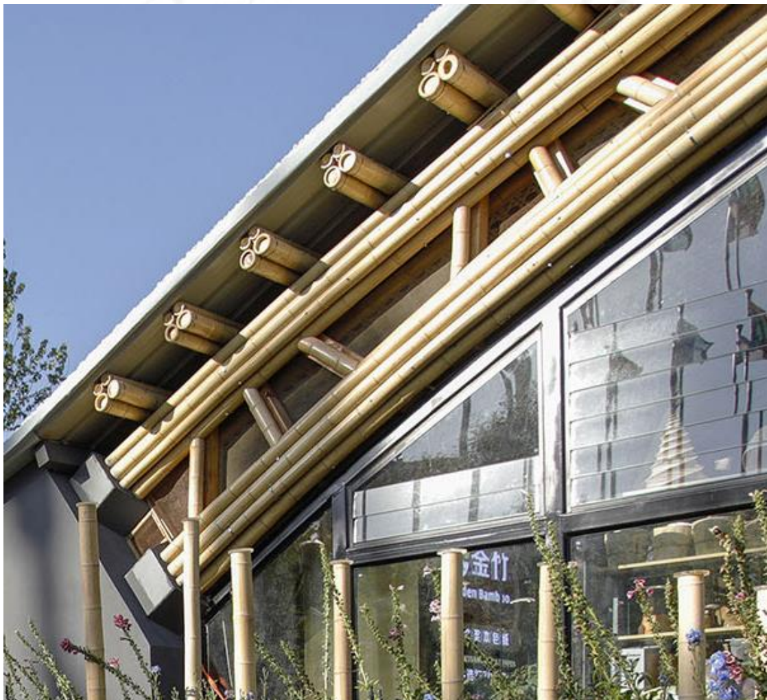
Figura 5.61 Vista Exterior de vigas
