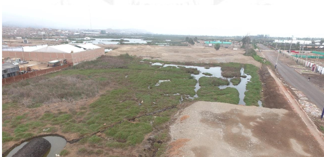
Figura 6.44 Vista del terreno al humedal
