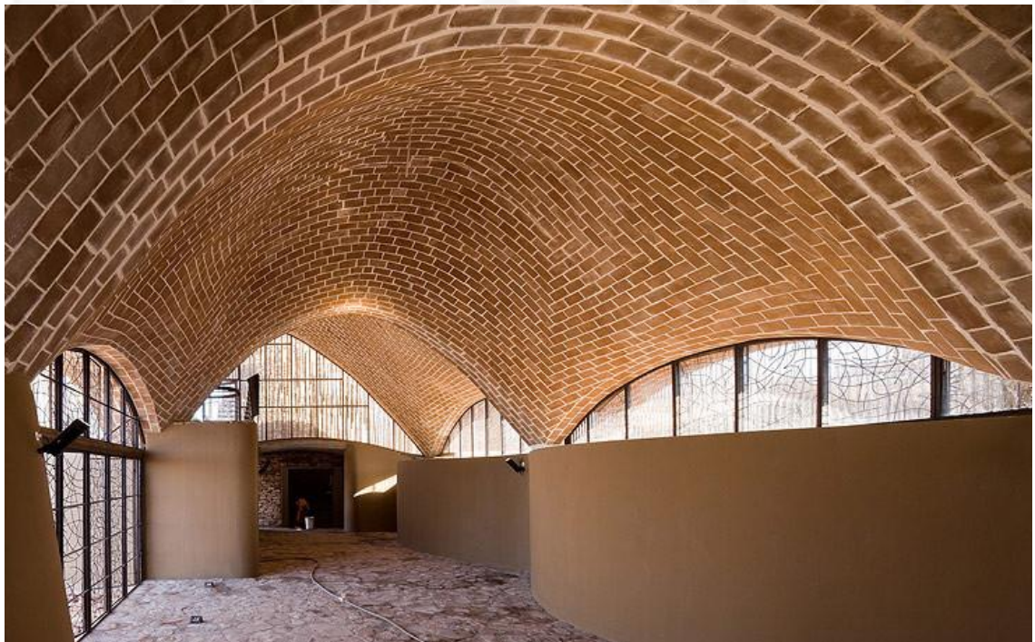
Figura 5.35 Interior de una de las cúpulas
