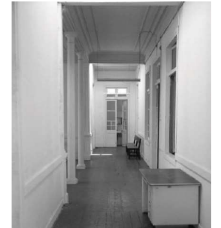
Imagen 100. Cason Villán: Pasadizo de distribución. Fuente: Delgado (2013).
