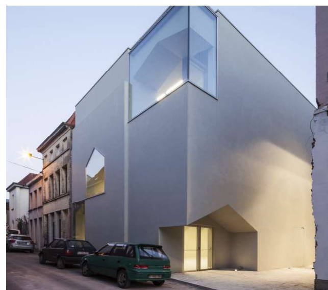
Imagen 66. Entrada posterior: se deja un retiro y el ingreso se coloca de manera perpendicular a la calle. Fuente: Van de Velde (2017)
