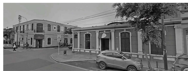
Imagen 96. Fachada de los lotes escogidos - Cafeterías Fuente: Google Earth (2015).
