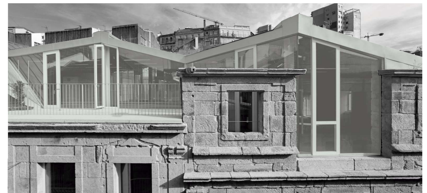
Imagen 78. Vista desde el exterior Fuente: Fotografía de Hector Santos Díez
