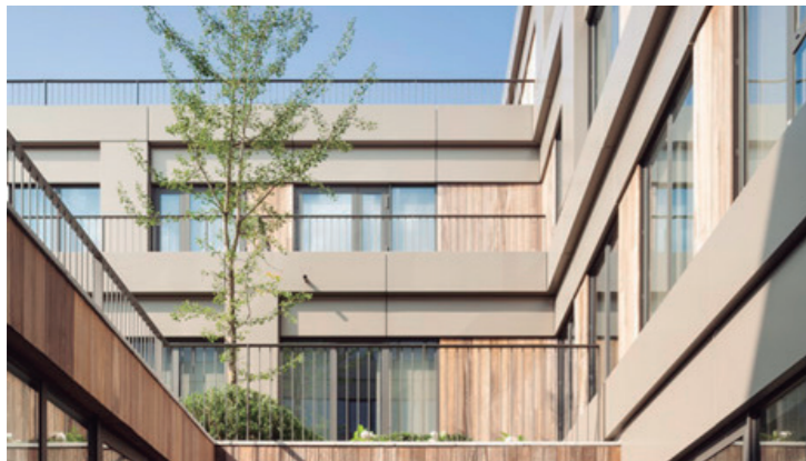
Imagen 111. Casa de retiro Mayerhof / Arean Architects. Fuente: Dezeen (2014).
