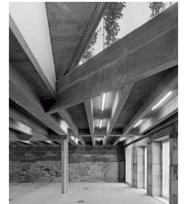
Imagen 84. Vista de la estructura interior Fuente: Fotografía de Hector Santos Díez
