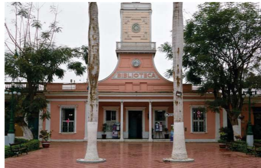
Imagen 41. Fachada de Biblioteca Municipal Fuente: Municipalidad de Barranco (2018)
