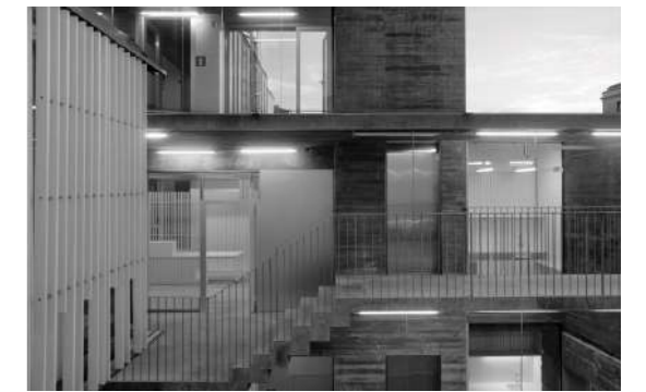
Imagen 83. Vista los balcones Fuente: Fotografía de Hector Santos Díez
