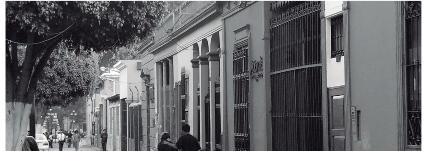
Imagen 26. Escala y arquitectura de las calles de Barranco. Fuente: Barranco Informa (2010).
