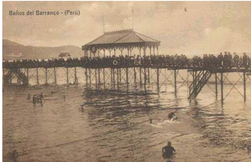
Imagen: Baños de Barranco (Municipalidad de Barranco)
