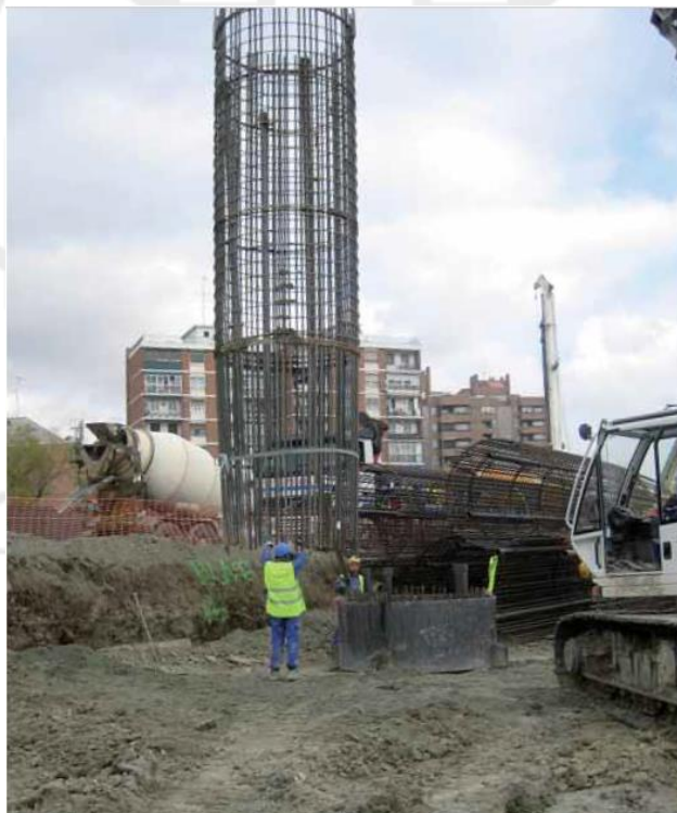
Armadura de cimentación - Pilotes. Fuente: (Ayuntamiento de Madrid)
